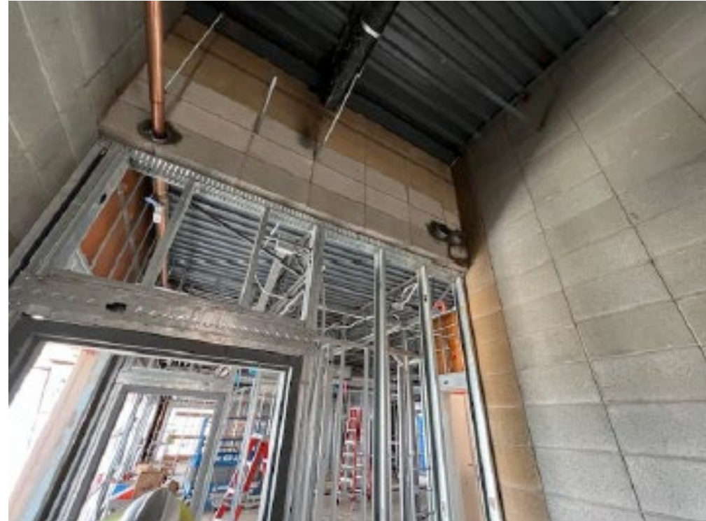
MEP Rough-in / Fire Suppression / HM Door Frame /
