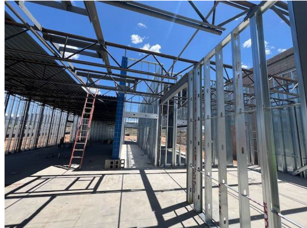
Metal stud framing
