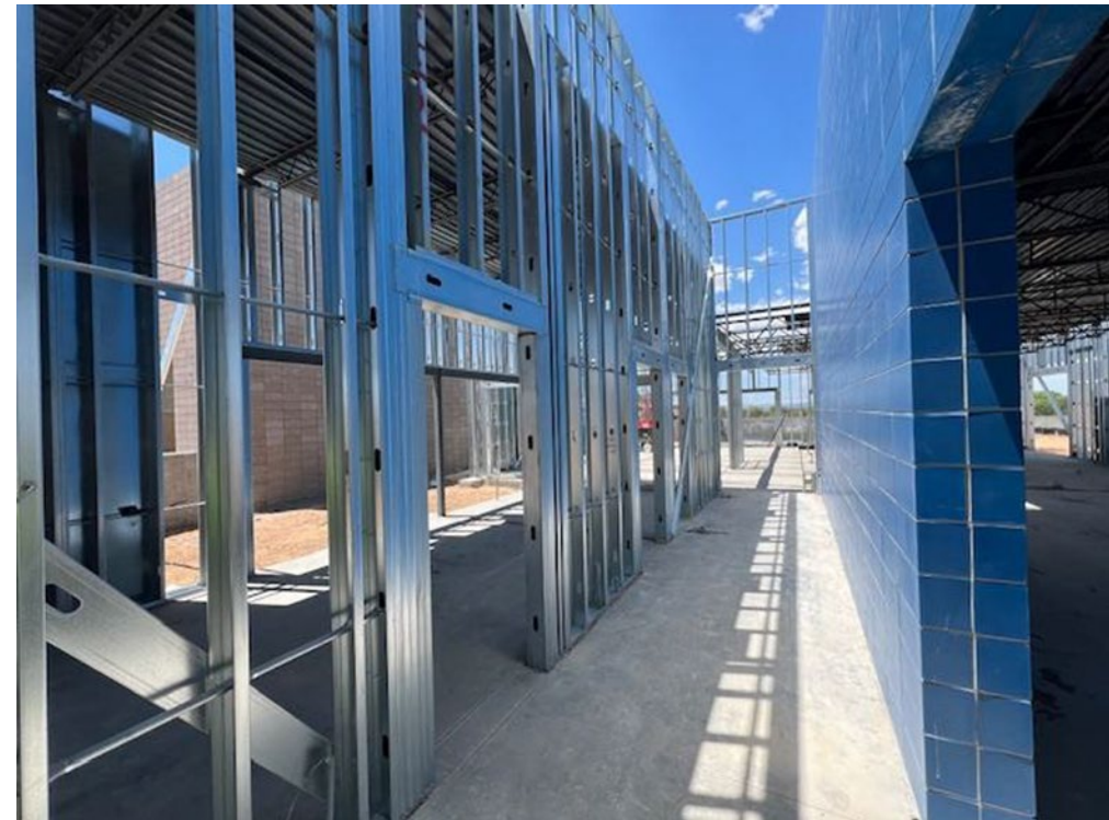
Steel stud erection and door frames
