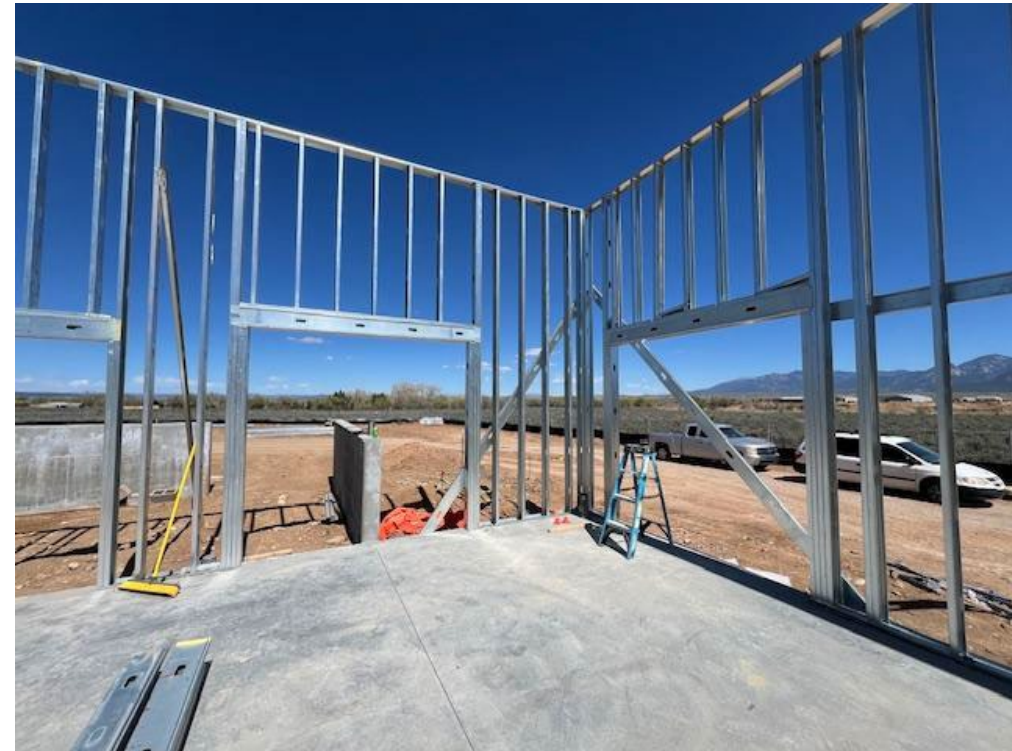
Metal stud framing
