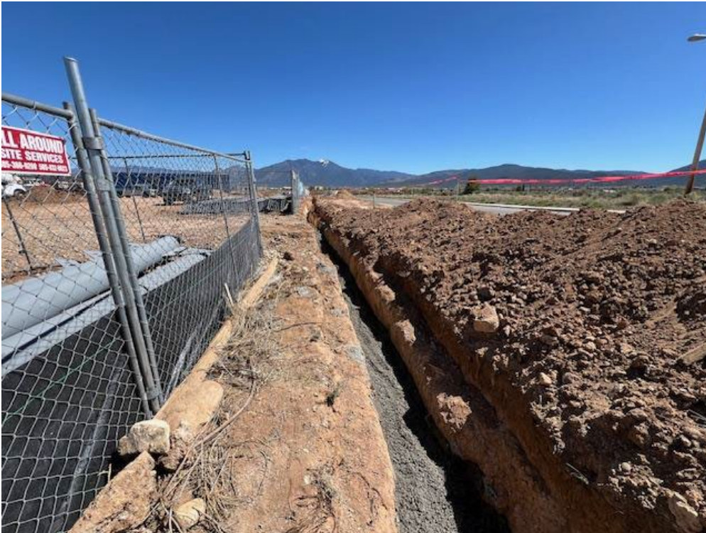
Concrete to encase conduit
